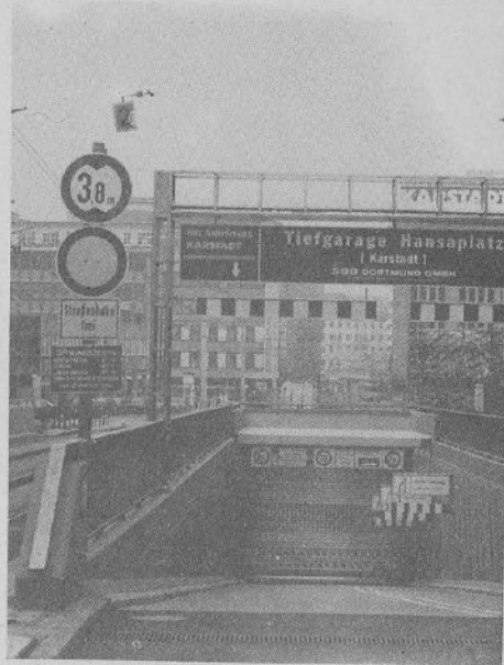
Schafft noch mehr Autoverkehr: der Bau von Tiefgaragen, hier Hansaplatz
