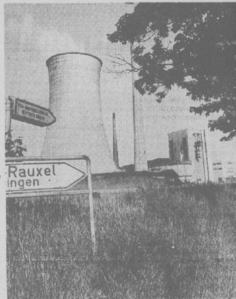
Auf dem Gelände des Kraftwerkes Knepper in Oestrich wollen VEW und Veba Kraftwerke Ruhr eine Müllverbrennungsanlage bauen.
