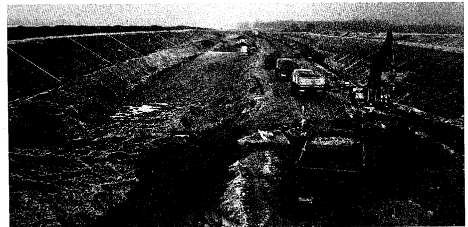
Großbaustelle NS IX / L 609n in DO-Mengede (Nov. 87)
